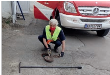
Das gesamte Hydrantennetz wurde überprüft
