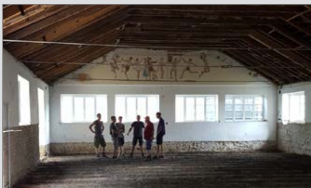
Am 7. Juni begannen die Abbrucharbeiten.
