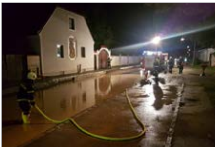
Baustelle nach Starkregen überflutet
