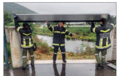
Hochwasserschutz-Generalaufbau mit den Feuerwehren Langenlois und Gobelsburg
