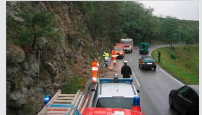
06.09.2007: Alarmierung nach einem Felssturz auf der B34
