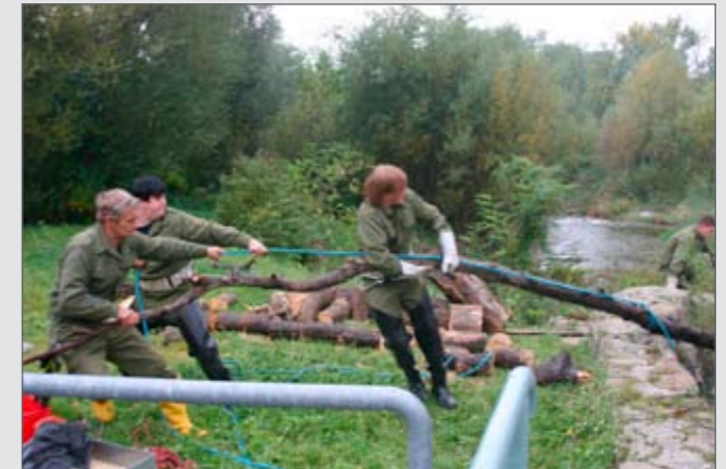
06.10.2007: Reinigung der Wehranlage von Schwemmholtz
