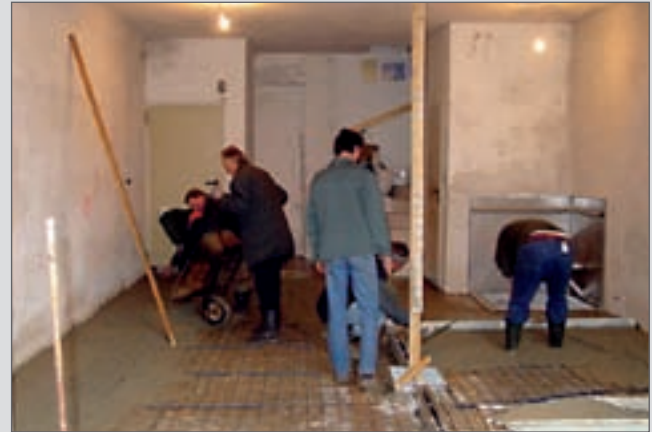
04.03.2006: Betonieren der Fahrzeughalle
