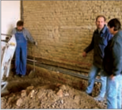
24.01.2006: Abbruch des unterspülten Hallenbodens
