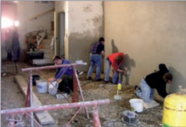
18.02.2006: Innenputz der Fahrzeughalle
