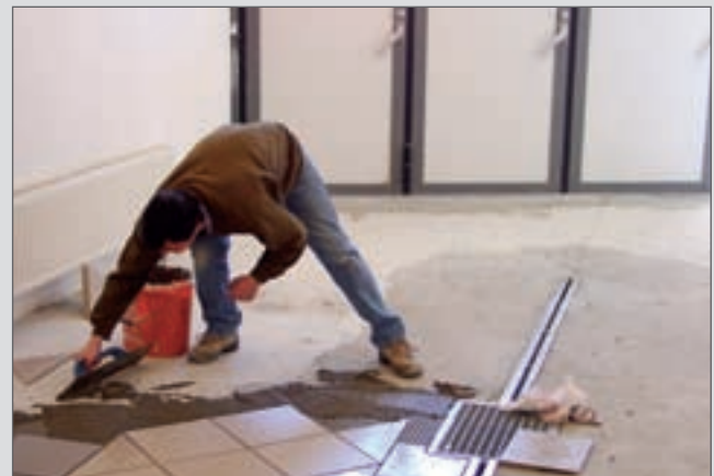
01.04.2006: Fliesen verlegen in der Fahrzeughalle
