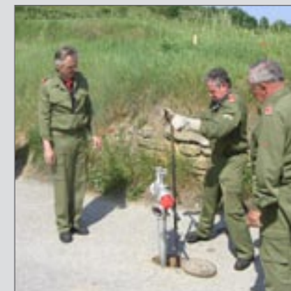
29.05.05: Übung der 1. Gruppe. Hydrantenüberprüfung und Funkverkehr
