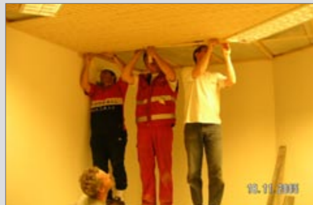
Schließlich wird auch der Innenausbau abgeschlossen
