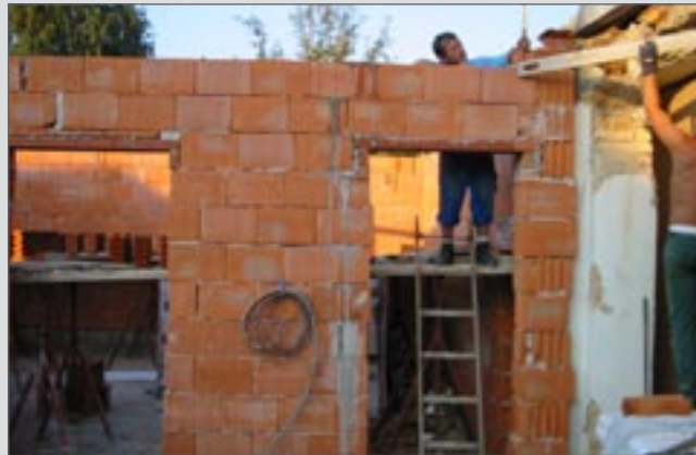
Die Umrisse des Neubaus sind schon sichtbar
