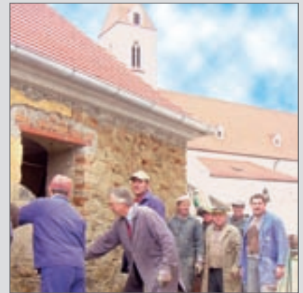
13.11.04.: Arbeitseinsatz – die FF Zöbing hilft beim Putz abschlagen im Pfarrhof
