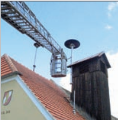
28.08.04.: Montage der neuen Sirene mit Drehleiter der FF-Langenlois
